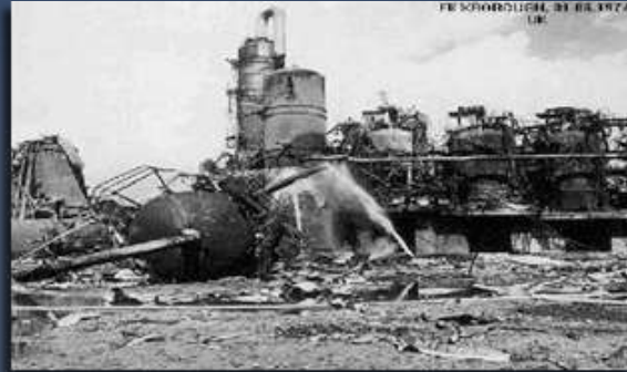
Explosão em Flixborough Inglaterra 1974
